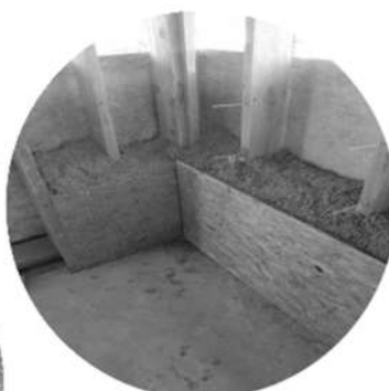
Опалубка из ОСБ
